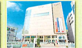
PHOTO:みずほ不動産販売HPより
